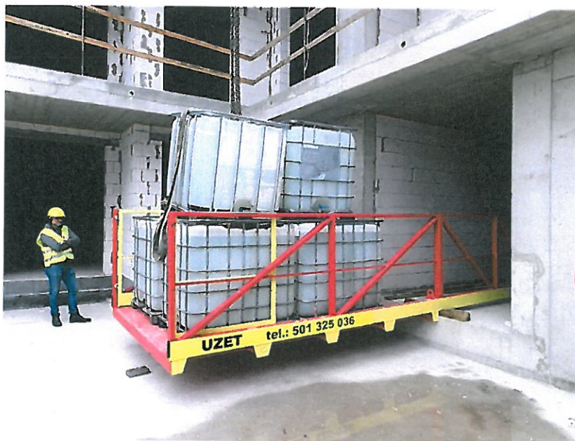
Rys 1. Próba obciążeniowa rusztowania (podestu przeładunkowego) UZET – obciążenie próbne 62,9 kN
